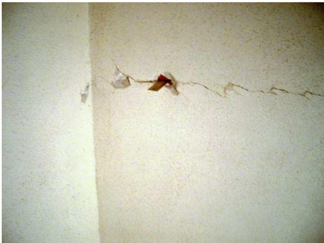
Risse, Bruch und Verschiebung quer an der Ostwand unter der Deckenplatte EG.
