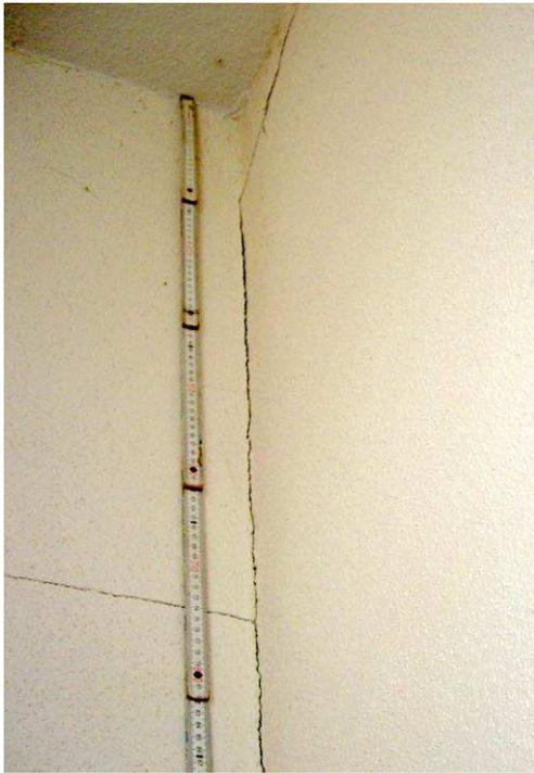
Risse, Bruch und Verschiebung quer einer tragenden Innenwand im OG sowie an der Nordwand
